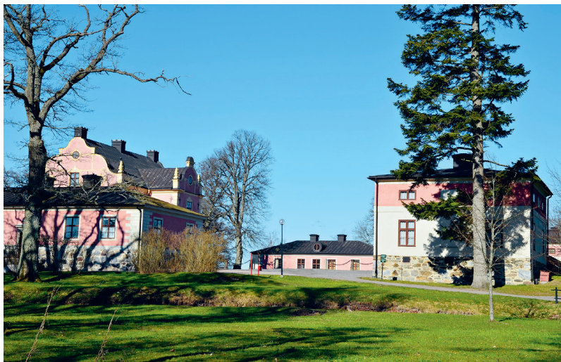
Skånelaholms fem byggnader. Foto: Irina Romanenko.
